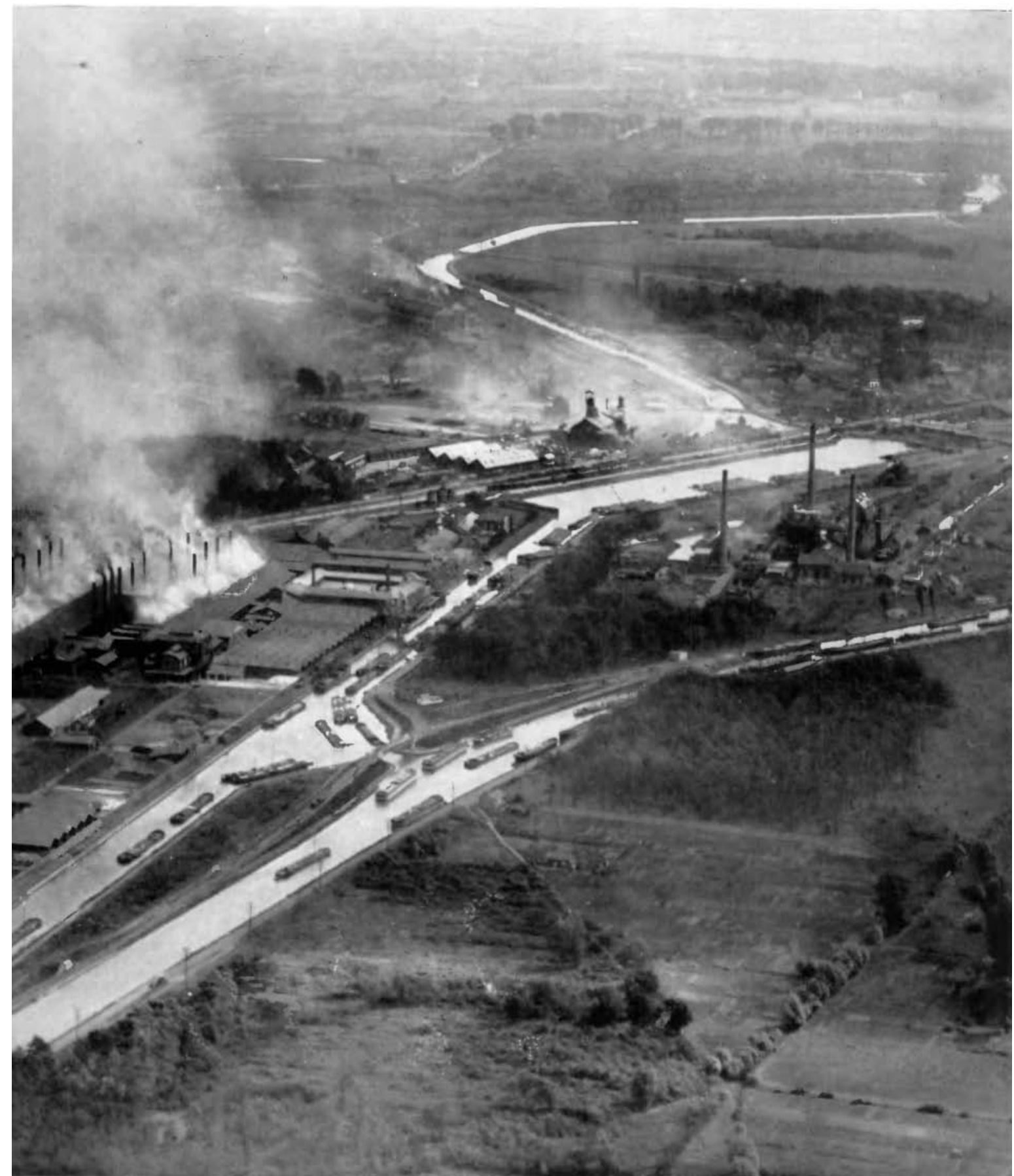
Vue panoramique de l'Usine d'Auby-les-Douai (Nord)
